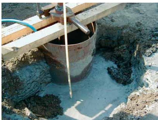
Bild 9: Bis GOK aufgestiegene Ton-Zement-Suspension
