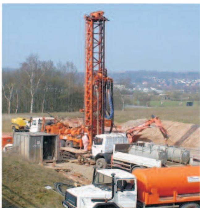
Herstellung einer 500 m tiefen Beobachtungsbohrung in Hessen
