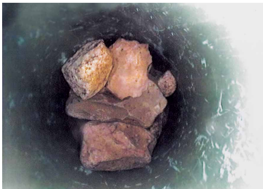
Bild 3 ■ Vandalismus – mit Steinen aufgefüllte GWM.
