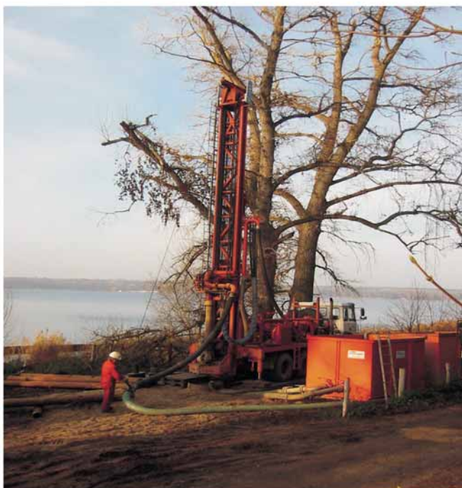
Brunnenbohrung für die Trinkwassergewinnung am Berliner Wannsee .
